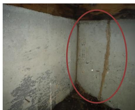
床が下がるとの事で実際調査したところ、シロアリが発生してました。右写真はシロアリの侵入した経路。
