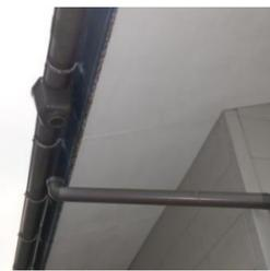
点検で発見しました屋根、外壁の痛みや雨樋の外れ。記載した写真は点検時の実際の写真です。
